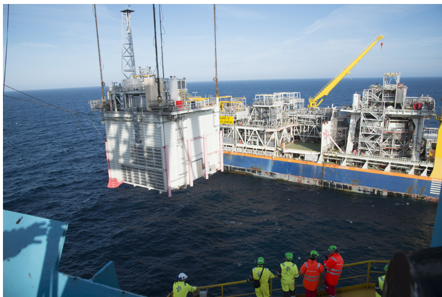
Åsgard havbunns kompressorprosjekt er kommet i drift. Her er løftet med en modul til Åsgard A-skipet. Foto: Statoil
