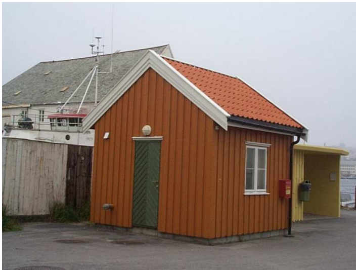
Pumpestasjon P14 Salbukta
