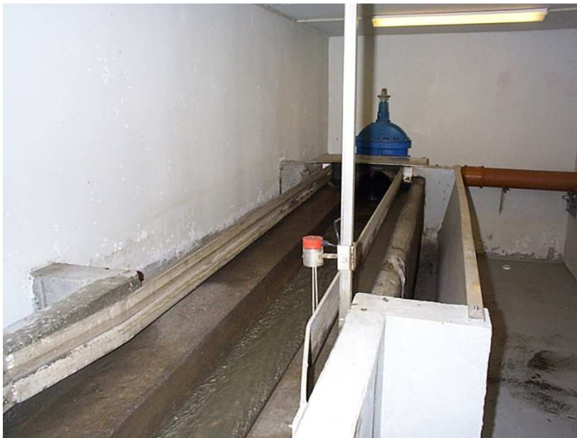
Regnvannsoverløpet i Kaibakken
