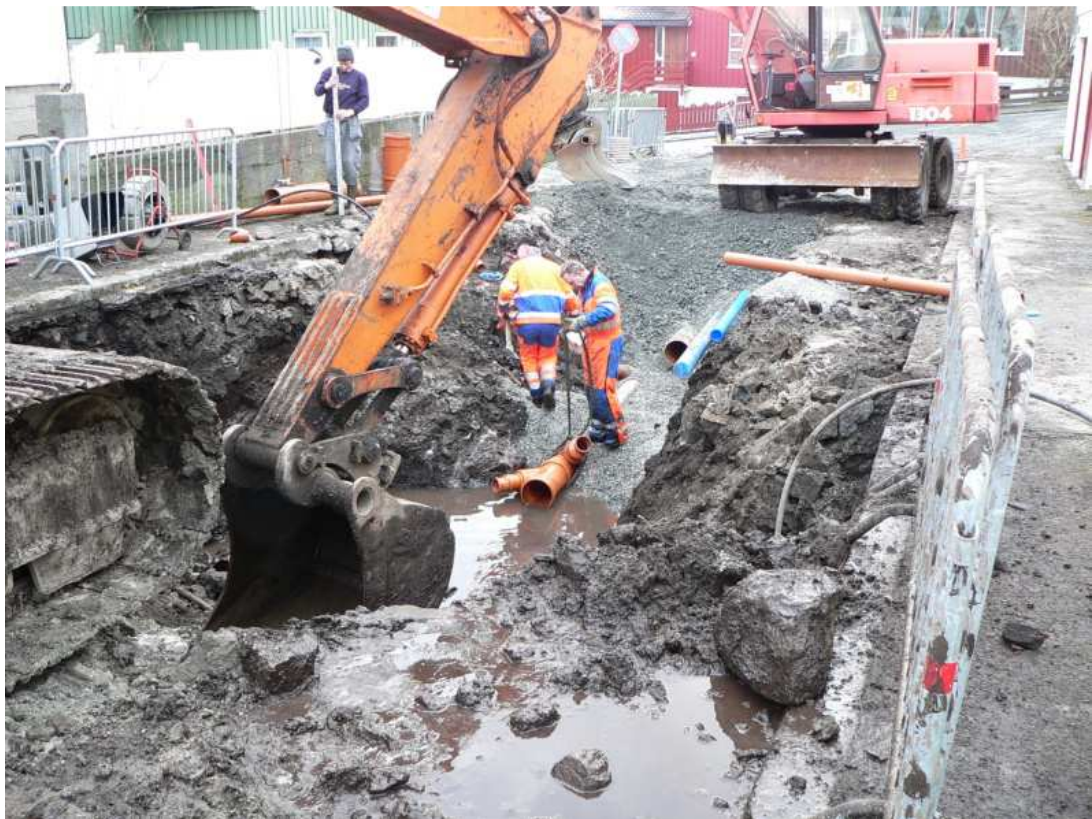
Typisk arbeidssituasjon ved utskifting av ledningsnett
