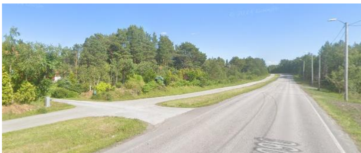
Figur 2-18: Typisk snitt av Kvalvågveien vest for krysset Kvalvågveien x Kvalvikveien. Gang- og sykkelveg langs strekningen. Flere avkjørsler som krysset gang- og sykkelveg. Mangler skilting av gang- og sykkelveg.
