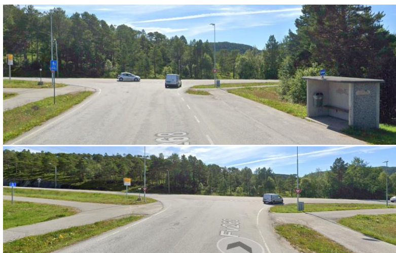
Figur 2-21: Tilrettelagt krysningspunkt binder sammen gang- og sykkelveg på begge sider. Mangler skilt 522 Gang- og sykkelveg på vestlig side av krysset. (Google Maps, juni 2024)
