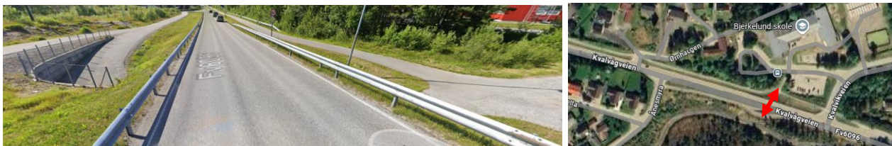
Figur 2-19: Undergang ved dagens Bjerkelund skole og Ånesmyra.
