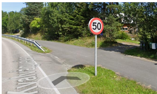
Figur 2-17: Avkjørsel langs fv. 6096 Kvalvågveien som krysser gang- og sykkelveg. Dårlig sikt på grunn av vegetasjon.
