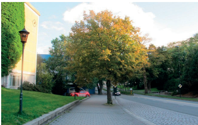
Figur 5.1.6 Mot vest avgrenses planområdet av Langveien, byens viktigste hovedfartsåre med kollektivdekning /busstraseer. Langveien vist med retning nord/sør. På den andre siden av Langveien mot vest ligger grøntdraget som et langstrakt rekreativt parkområde. Som det ses er der per i dag store løvtrær langs Langveien. Disse gamle trær ønskes bevart og tjener både som god skygge for operaens glassfasade og lydabsorbent når det gjelder trafikkstøy fra Langveien.
