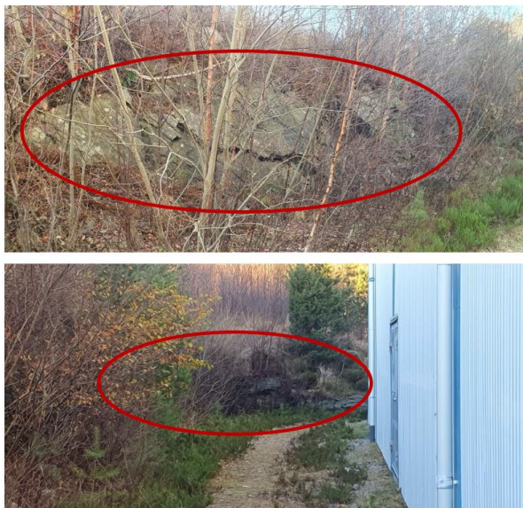
Figur 6: Bilder fra befarings i uke 47 i 2022 viser berg i dagen ved Freihallen.
