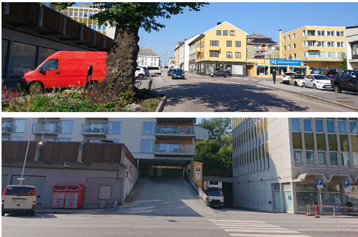
Figur 9-3: Foto fra kryssområdet Fosnagata X Astrups gate ved Helsehuset, som barn og unge har registrert som uoversiktlig ved at «det kommer noen kjørende fra alle mulige retninger!».
