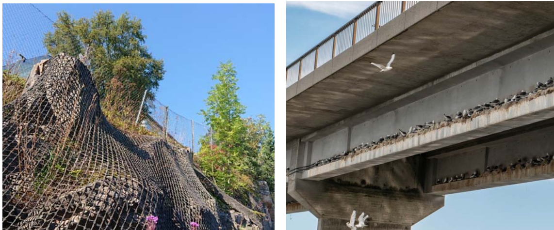
Figur 11-2: Foto viser netting over bergknauser på Devoldholmen, og krykkjekoloni under Gjemnesbrua på E39.
