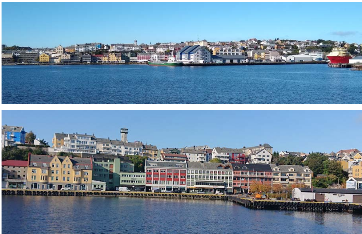
Figur 8-3: Øverst er foto av Devoldholmen med gjenreisningsbyen i bakgrunnen og Havneterminalen til Kristiansund og Nordmøre havn sentralt i bildet. Nederste foto viser bebyggelsen langs Vågekaia og brannstasjonen på toppen, og Nordmørskaia foran til høyre.
