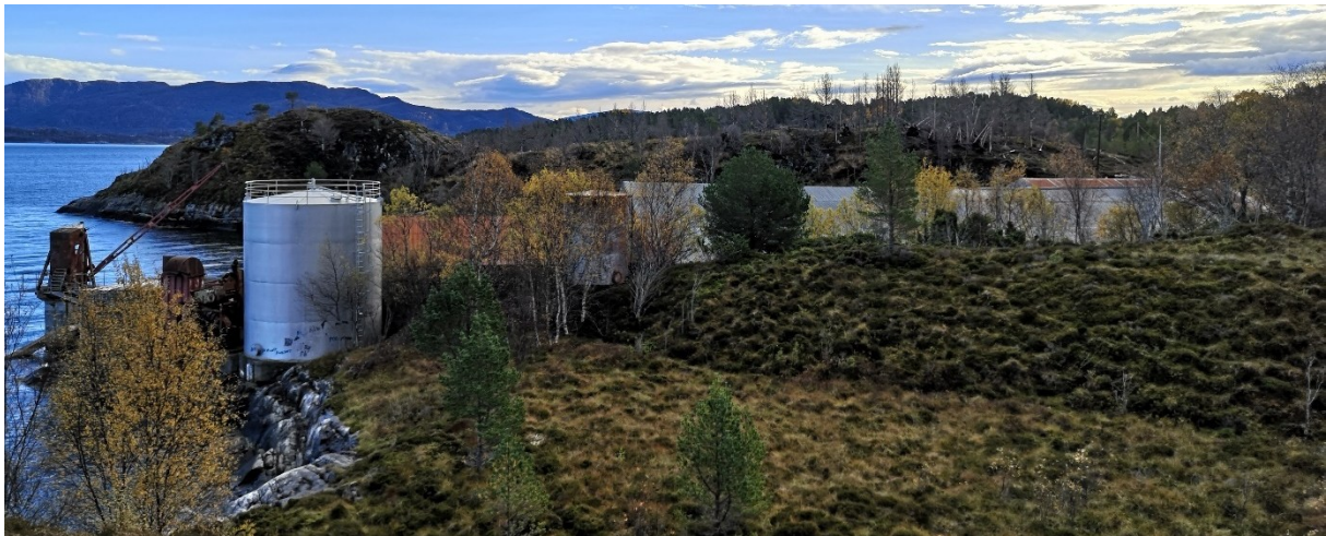
Figur 17 Bilde av tangfabrikken sett fra nord (planområdet).
