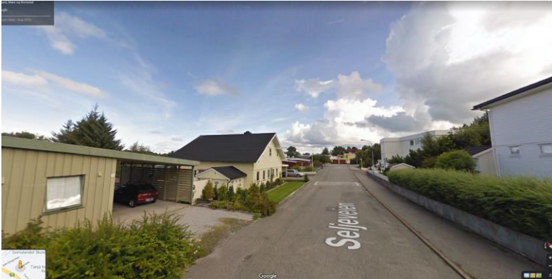
Figur 3: Bilde tatt fra google maps, som viser dagens situasjon langs Seljeveien.
