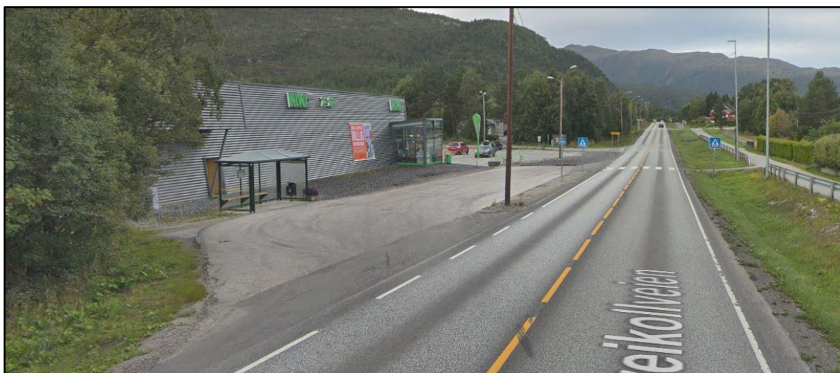
Figur 7: Bussholdeplass og avkjøringen fra Rv70 til Einerskaret, sett fra nordøst (Kilde: Google Maps)
