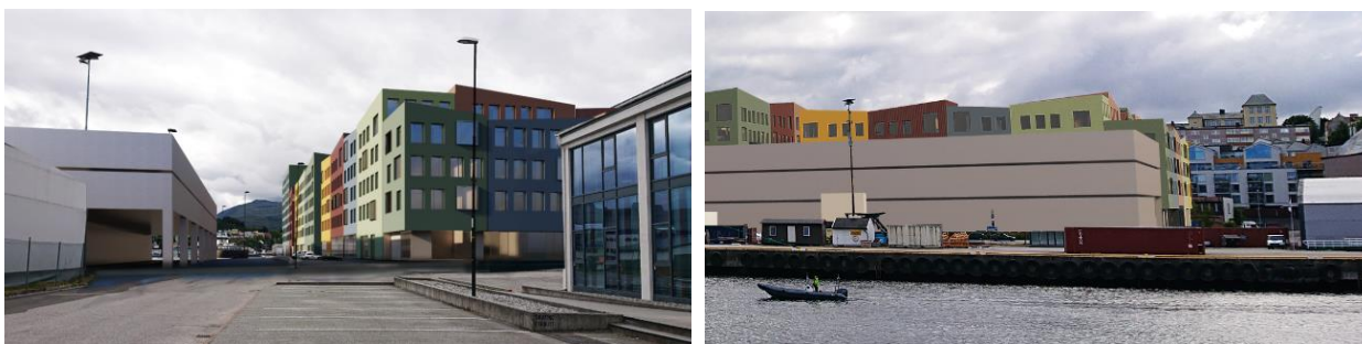
Figur 8. Fotomontasjen t.v. viser Astrups gate sett fra Hollendergata ved NAV, med Campus Kristiansund til høyre, nytt kombinasjonsbygg/bussterminal til venstre og Freikollen som ny fondvegg i sør. Fotomontasjen t.h. viser Campus Kristiansund langs Astrups gate sett fra Milnbrygga og Klippfiskmuseet, med Allanengen skole ruvende som fond i horisonten.
