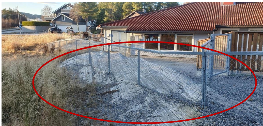
Bilder 5-2: Berg i dagen mot nord av tiltaksområdet ved Veslefrikk barnehage.
