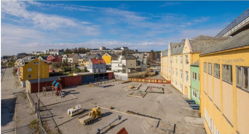
Figur 19: Gomalandet gamle skole ses til høyre i bildet og Strandgata til venstre i bildet.
