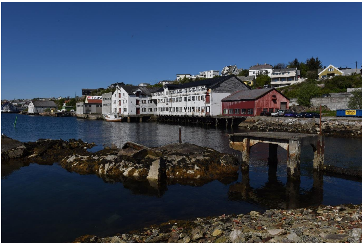
Figur 17: Eksisterende bebyggelse på Strandgata 18-26 sett fra Nordholmen. Bebyggelsen har ikke registrert verneverdi og forutsettes revet.
