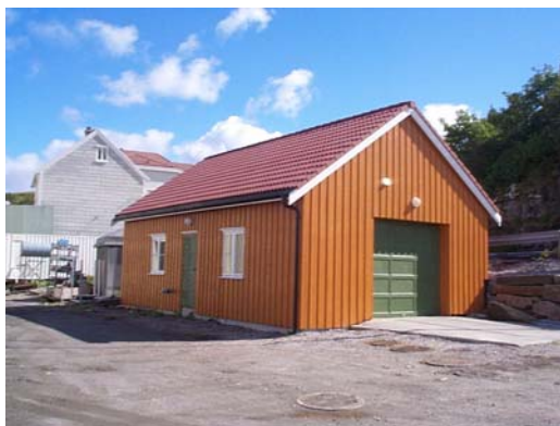
Renseanlegg RA9 Heinsagata
