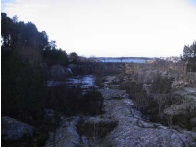
Reinvasdammen med Sørsundbrua i bakgrunnen
