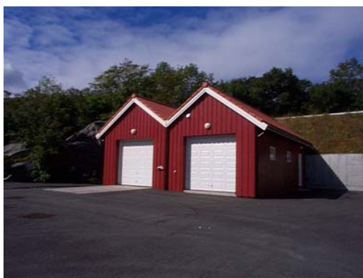
Renseanlegg RA6 Jonassenskjærva
