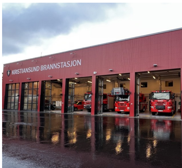
Bildet viser deler av garasjeanlegget for brannbiler på den nye brannstasjonen.
