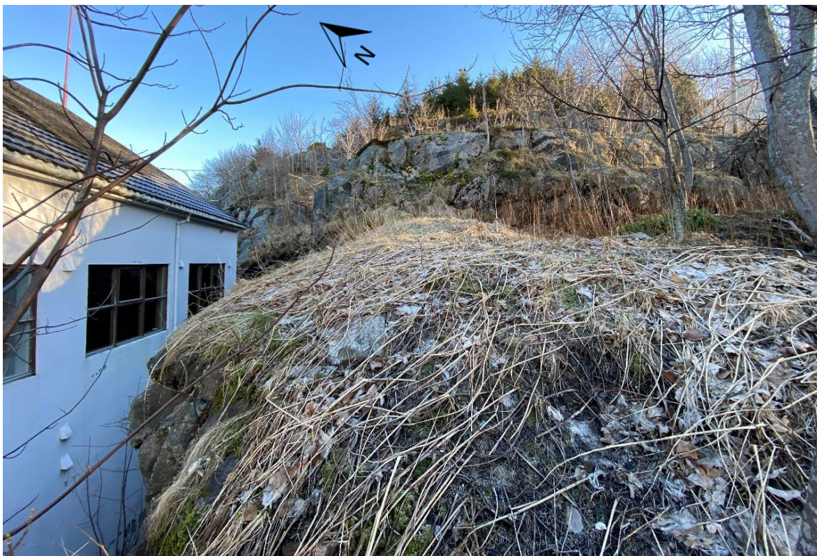
Figur 8: Terreng over bergskjæring mot sørøst.
