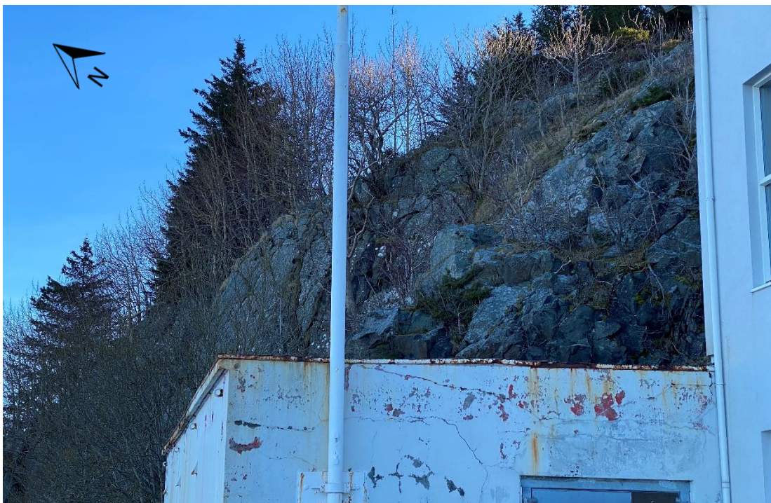
Figur 9: Bergskjæring mot nordøst, i bakkant av Grunden 22.
