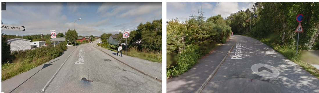
Figur 3-2: Bilder tatt fra google maps, som viser dagens situasjon langs Røsslyngveien.
