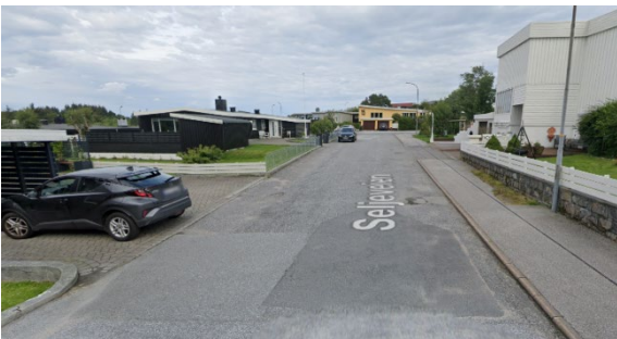
Figur 3-4 Bilde tatt fra google maps, som viser dagens situasjon langs Seljeveien.
