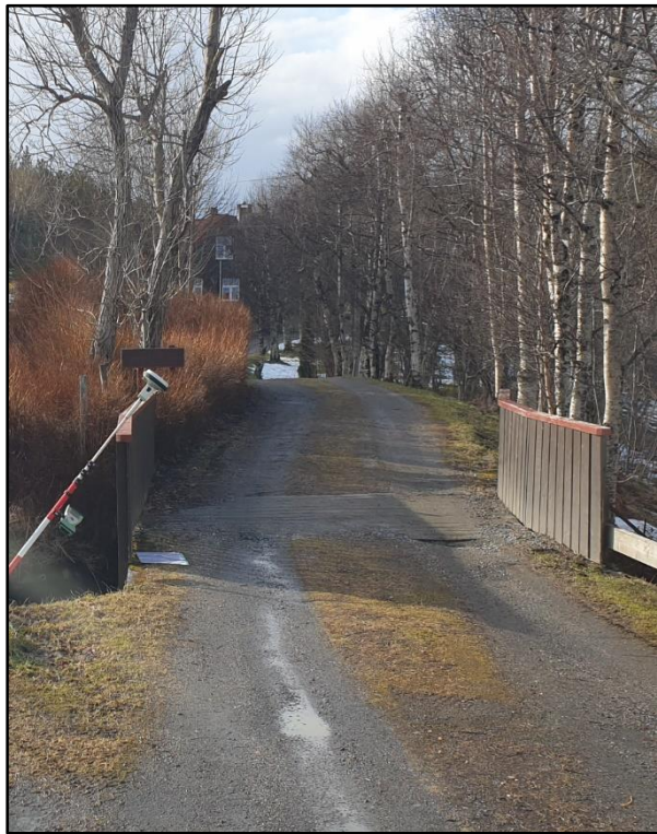
Figur 14 viser trebrua som bekken krysser under. (Foto: Kristiansund kommune)
