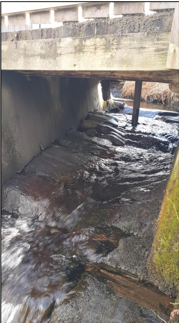
Figur 15 viser bilde av lysåpningen under trebrua. (Foto: Kristiansund kommune)
