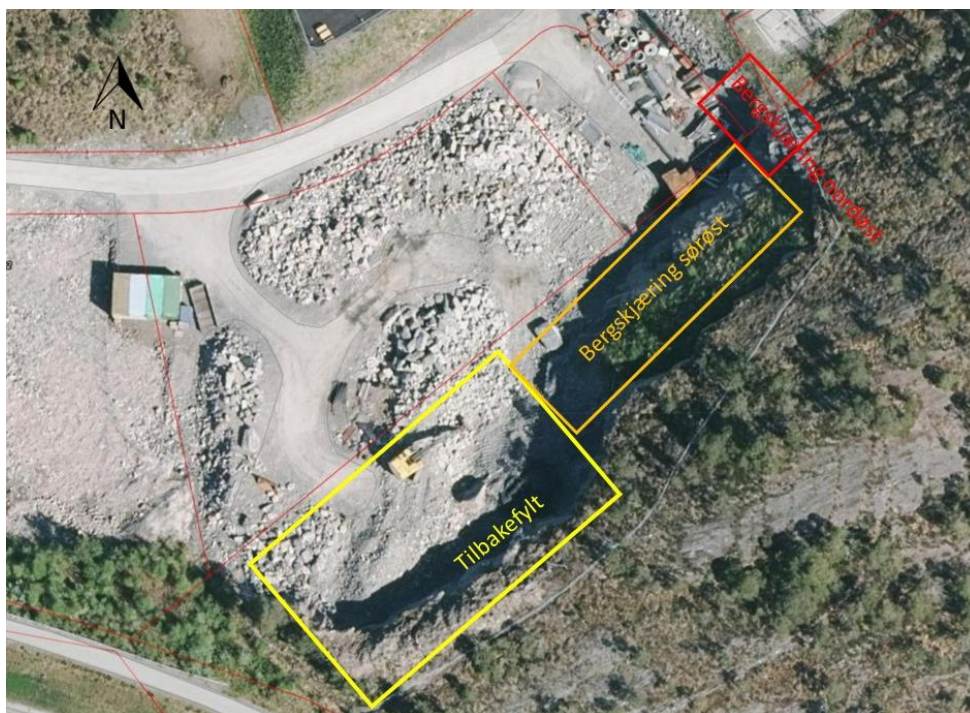
Figur 2: Flyfoto over planområdet. Inntegnet område hvor bergskjæring er tilbakefylt, og bergskjæring nordøst og sørøst.
