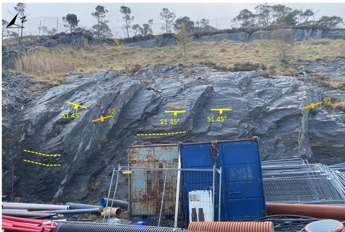
Figur 4: Bergskjæring sørøst. Østre del av bergskjæringen. Gjennomsettende oppsprekking er markert i foto.
