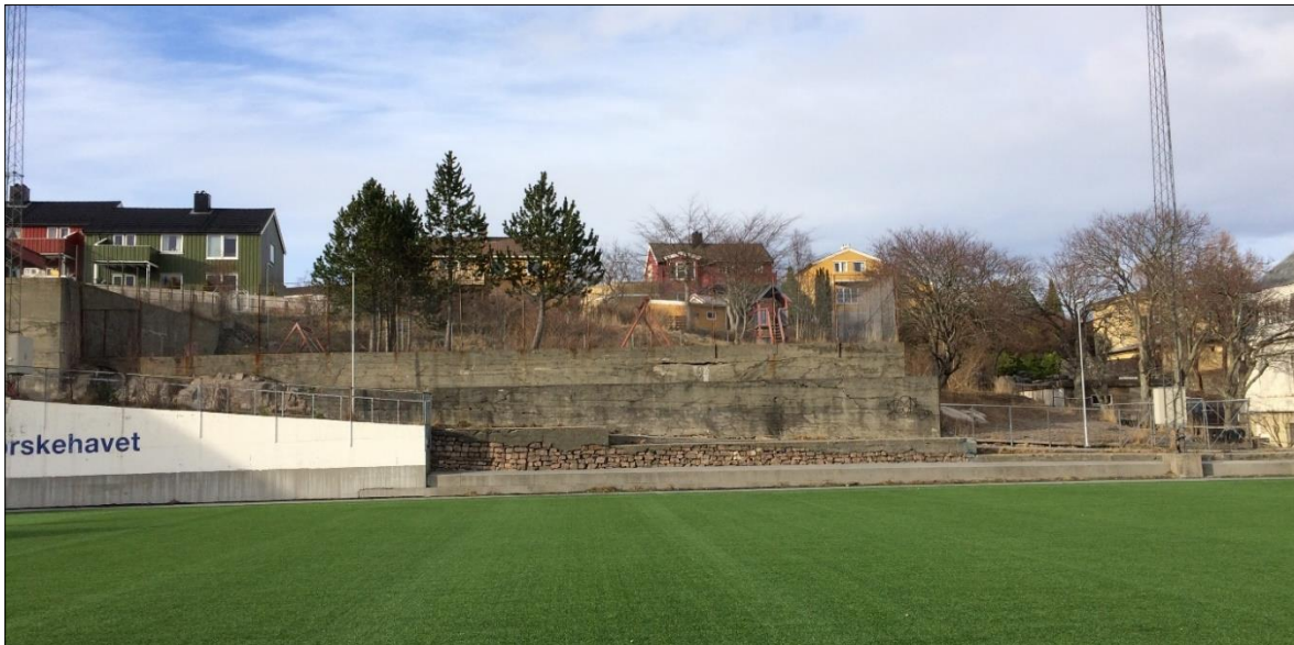
Bildet viser området som er tenkt utnyttet til uteområde for krisesenteret. Murene gir en naturlig høydeforskjell som skjærer for innsyn og som ivaretar sikkerheten til brukerne av krisesenteret. Kilde: Ikon Arkitekt & Ingeniør AS.
