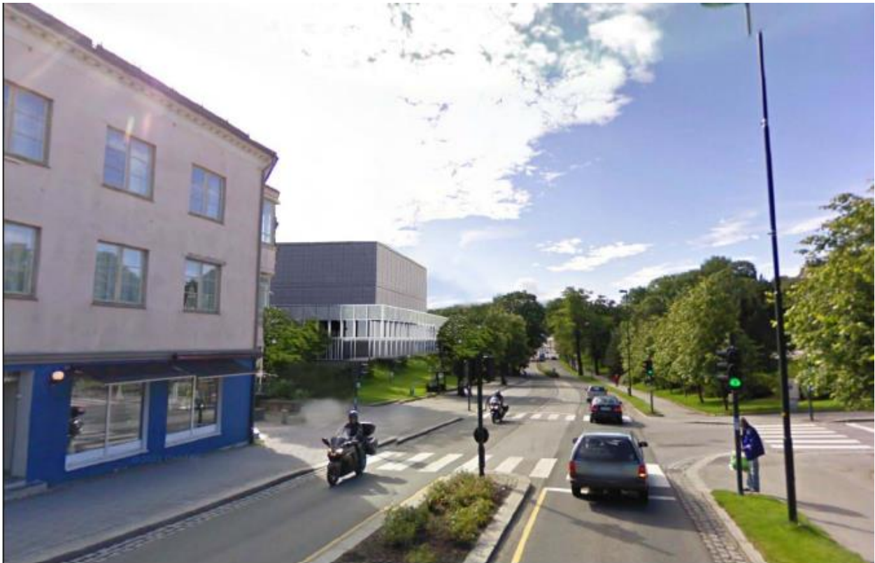
Figur 8: Nybygget fra standpunkt i Langveien mot sør.
