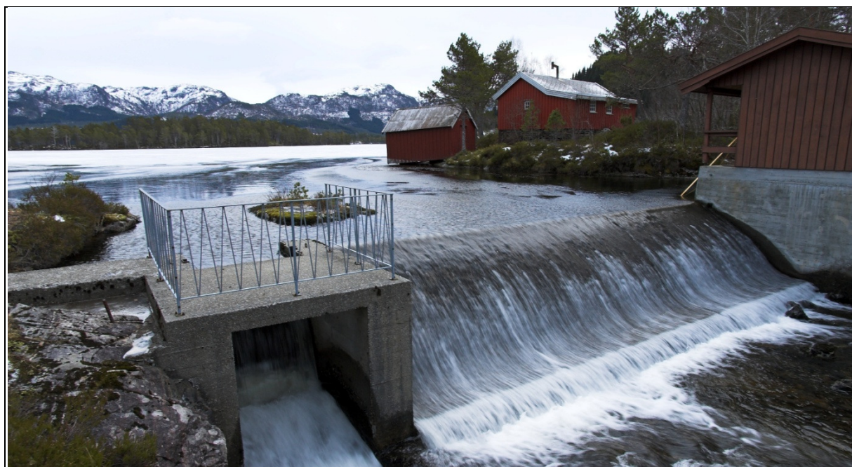
Dam ved utløp i nordvest
