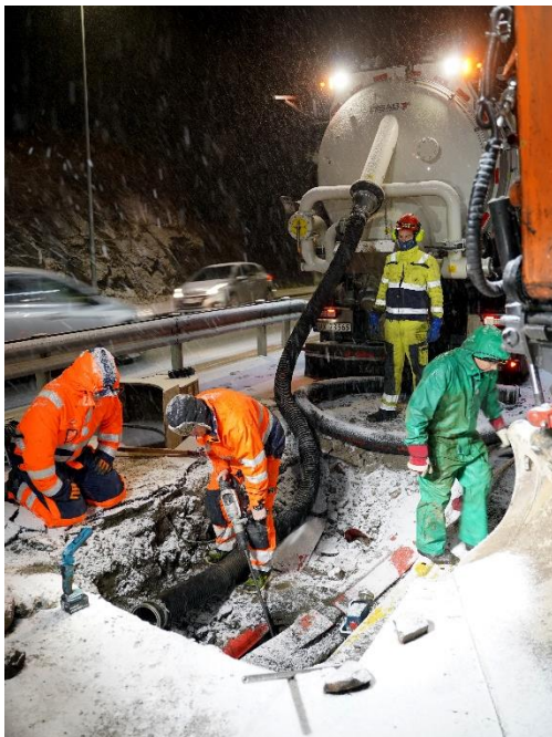
Reparasjon av vannlekkasje på Nordlandet. Kommunalteknikk i samarbeid med Multi Marine. Foto: Ingunn Strand
