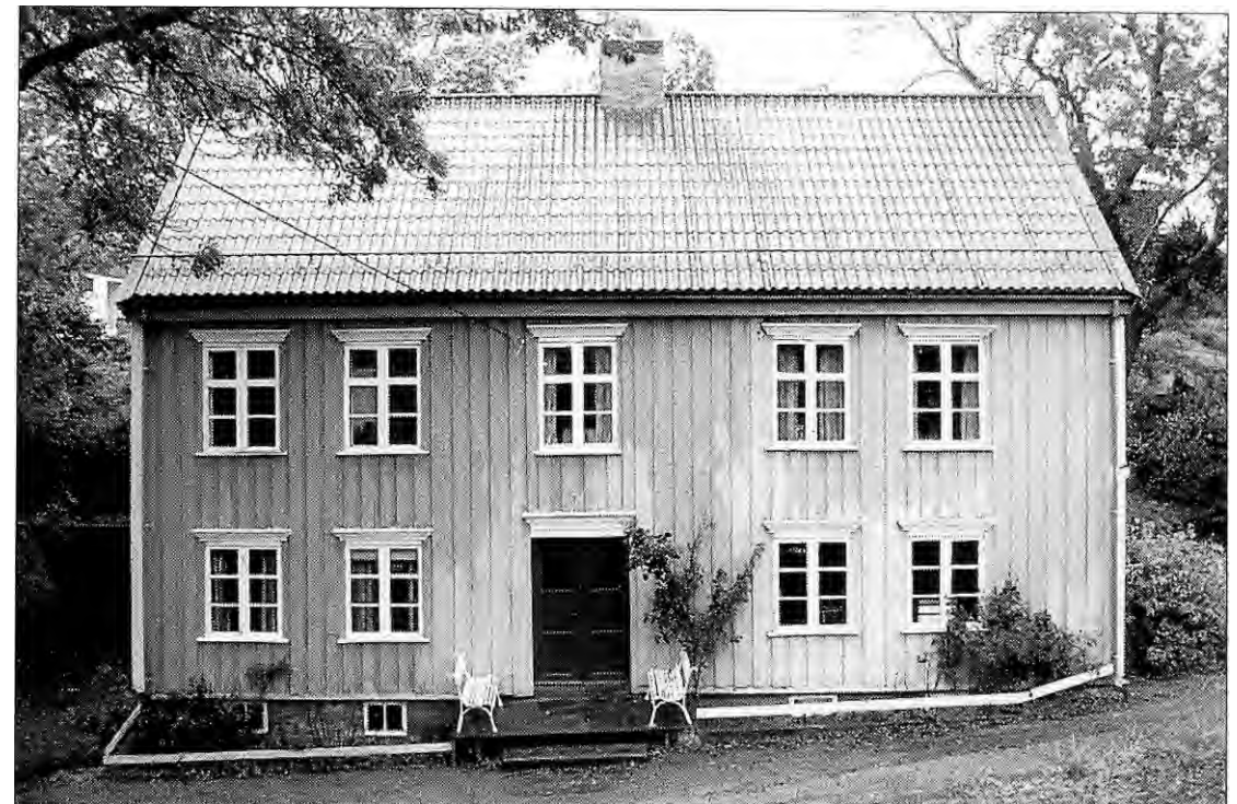
Fig.12. Hovedbygningens sydfasade. Foto: Christ Allan Sylthe, Fylkeskonservatoren.
