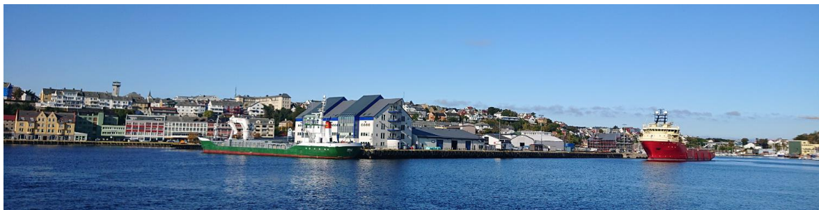
Figur 7-2: Foto av Devoldholmen sett fra havnebassenget. Havneterminalen sentralt i bildet, og flere båter ligger til kai ved Holmakaia til venstre og RORO-kaia til høyre.
