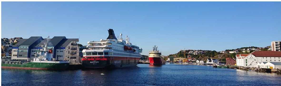
Figur 8-2: Foto av Holmasundet inn til den historiske Vågen, med Devoldholmen og Hurtigrutekaia til venstre, og de gamle hvite bryggene ved Klippfiskmuseet på Israelsneset til høyre. Skipsverftet Mellomverftet ligger lenger inn i Vågen. Kristiansund har fortsatt et aktivt og levende havnemiljø, med større og mindre skip som daglig legger til ved Devoldholmen og de andre kaiene rundt havnebassenget.
