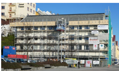
Vågeveien 4 bygges om til kommunalt administrasjonsbygg
