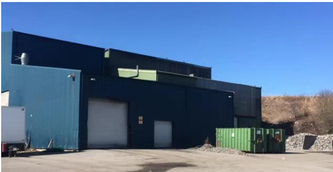
Figur 14: Omlastestasjonen på Hagelin.
