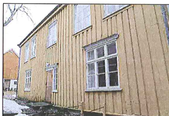
Figur 4. Hovedbygningen sett fra nordvest
