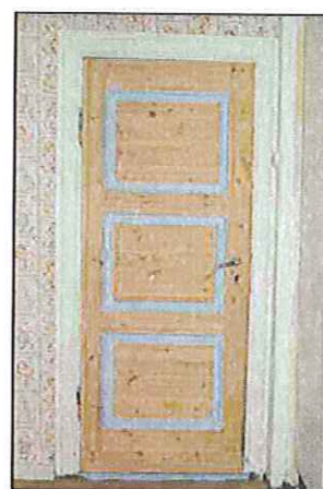
Figur 14. Dør på østveggen
