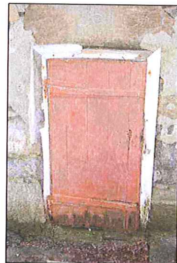
Figur 118. Dør på sørveggen
