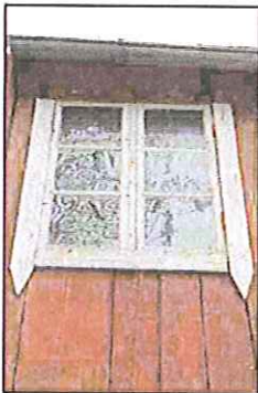
Figur 103. Vindu på sørveggen
