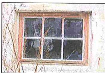
Figur 105. Vindu på vestveggen
