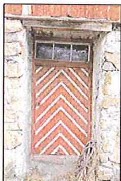
Figur 104. Dør på sørveggen
