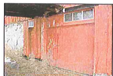
Figur 107. Dører på sørveggen
