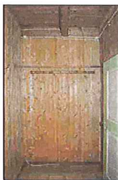
Figur 61. Rom 2.7 sett fra nord
