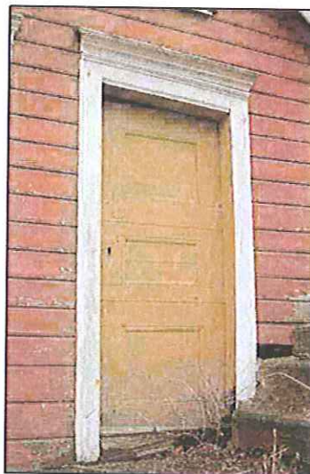
Figur 117. Dør på østveggen
