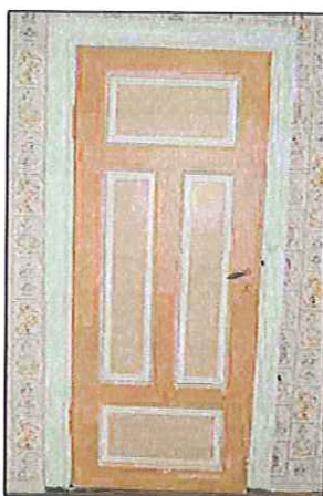
Figur 13. Dør på sørveggen
