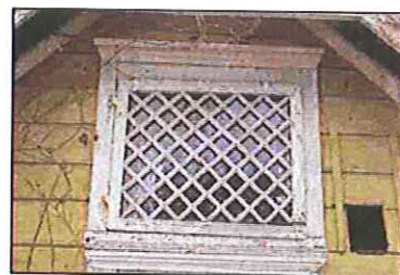
Figur 122. Vindu i gavlen
