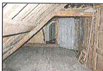
Figur 84. Rom 3.4 sett fra øst
