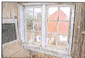
Figur 83. Vindu på østveggen. Til venstre i bildet lemmer med påmalt vindu.
