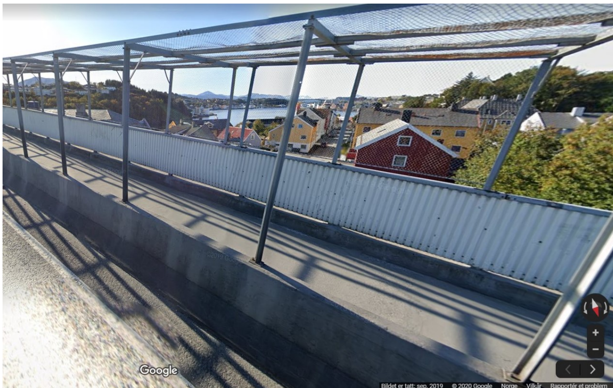
Figur 3-3: Nordsundbrua er i dag utstyrt med tett rekkverk langs hele bruas lengde, glidestøpt betongrekkverk mellom vegbane og fortau, og gittergjerde langs fortau i nordre ende.
