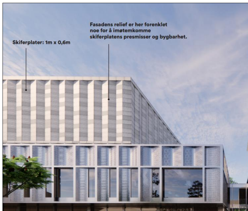
Figur 48: Eksempel på enkle bygningstekniske løsninger i glass, perforert aluminium og skiferkledning. Kilde: Henning Larsen arkitekter.
