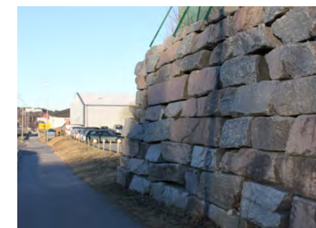
Mur gang- og sykkelveg Løkkemyra
