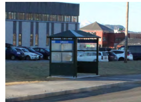
Holdeplass Løkkemyra, østgående
