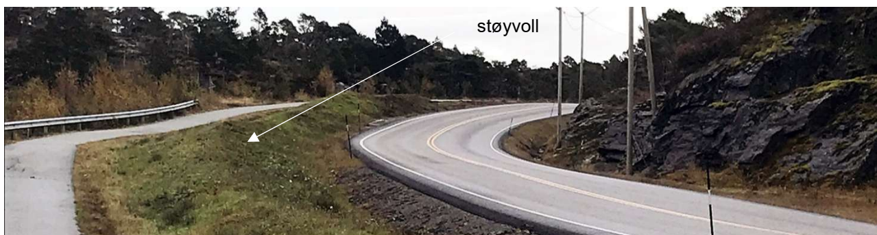
Figur 10 Foto av støyvollen ved Kvalvågveien mellom kjørebane og gang- og sykkelvei.
