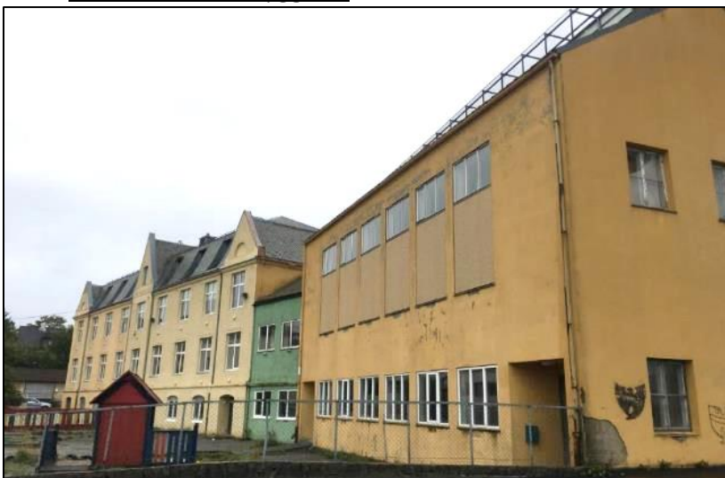
Gamle Goma skole sett fra sør.
