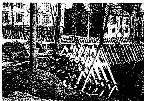
bilde 4: Bygging av bombesikre rom i Langveiens øvre park.
